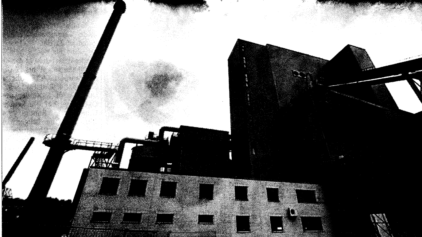
Geht bis Ende des Jahres ans Netz: Biomasse-Kraftwerk auf dem Monopol-Gelände in Mitte.
